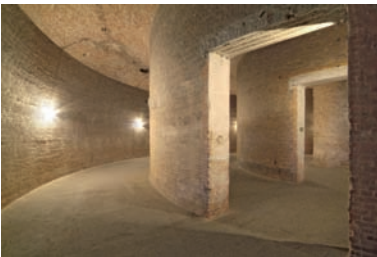
Großer Wasserspeicher © Roman März
